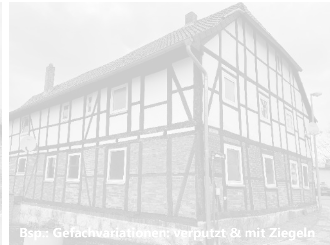
Bsp.: Halbstöckige Tonziegelverkleidung
