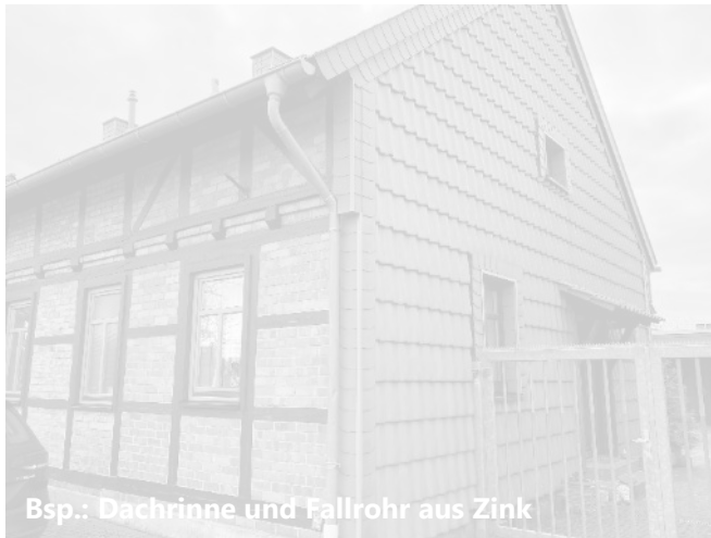
Bsp.: Krüppelwalmdach, Backstein-Schornstein
